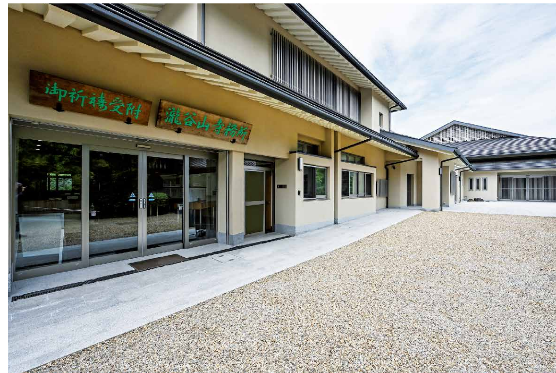
開創一千二百年記念事業として建設された寺務棟(手前)と無畏殿(客殿。奥)
