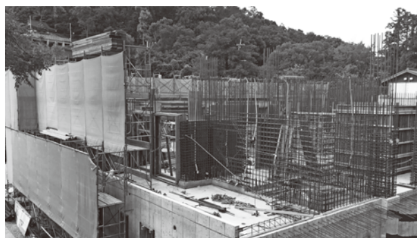
建設中の客殿棟
