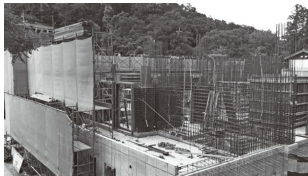
建設中の客殿棟
