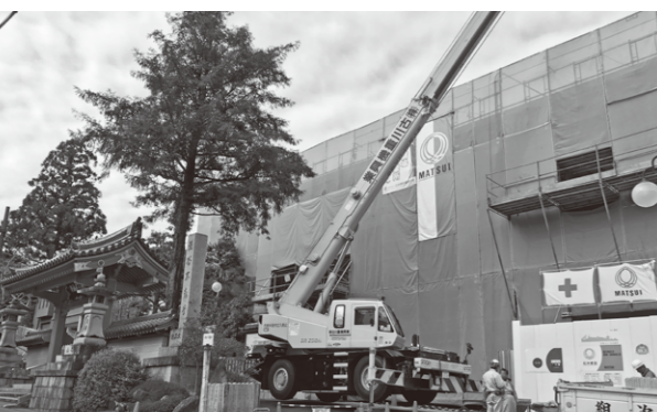
建設中の客殿棟
