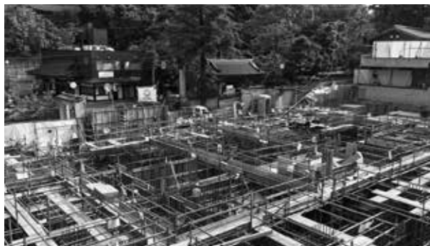
客殿棟 建設現場の様子
