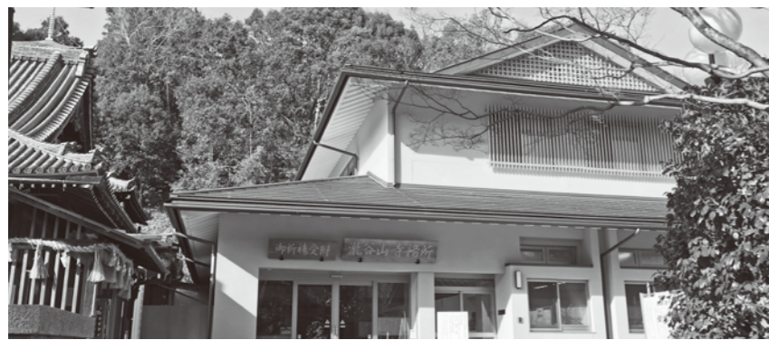
完成した寺務棟
